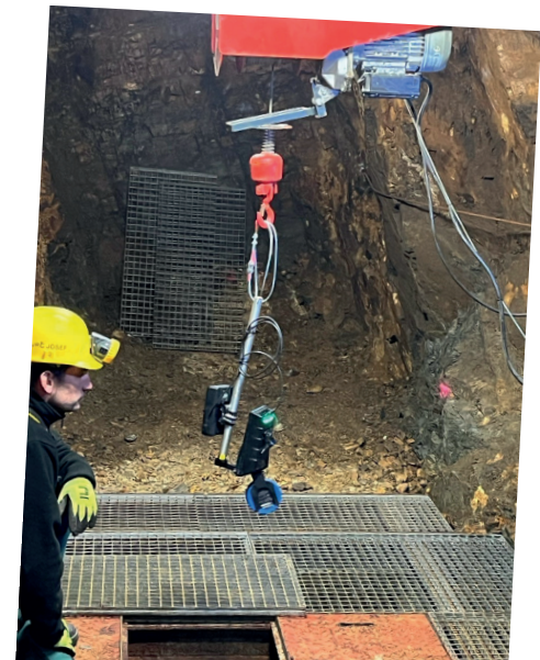
Spouštění 3D skeneru do pádového komínu z úrovně +40 m
